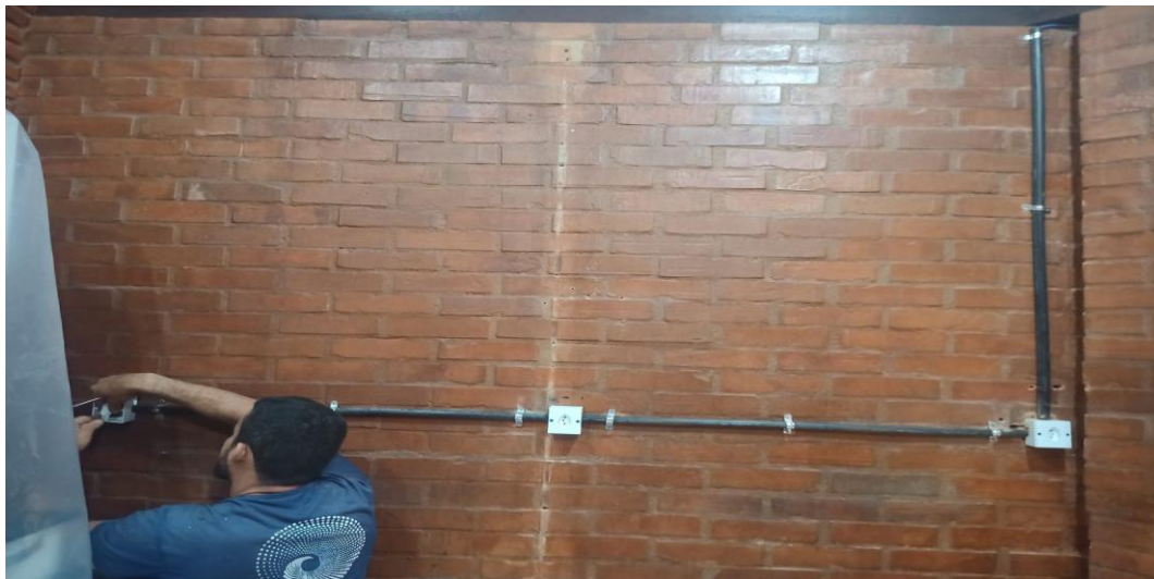
Figura 21. Cozinha administrativa. Substituição e ampliação de todo sistema elétrico: tomadas, cabos, plafons, eletrodutos e lâmpadas queimadas. Maio/2023.
