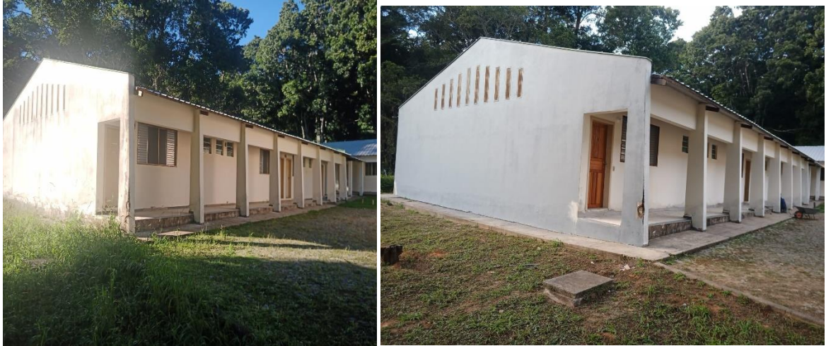
Figura 38. Alojamentos do Centro de Pesquisas. Pintura e aplicação de verniz em todas as estruturas: em andamento. Junho/2023.
