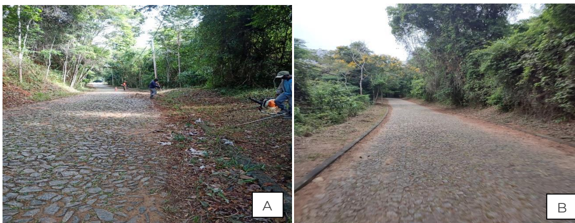
Figura 5. Poda de vegetação. A) Retirada de vegetação. B) Roçada e retirada de vegetação em pontos de maior crescimento nas margens da estrada principal de acesso ao Lago Dom Helvécio. Abril/2023.
