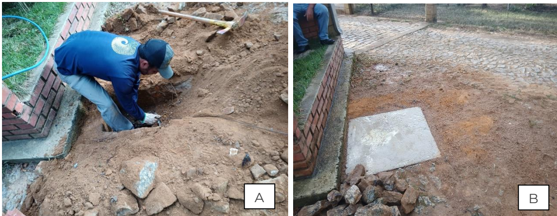
Figura 30. Portaria. A e B) Ação de desentupimento da rede de esgoto com construção de caixa de passagem para melhorar o fluxo de dejetos do banheiro da portaria principal da UC. Junho/2023.
