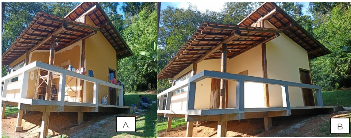
Figura 40. Centro de Fiscalização do Salão Dourado. A e B) Pintura da estrutura do centro de fiscalização finalizada. Abril/2023.
