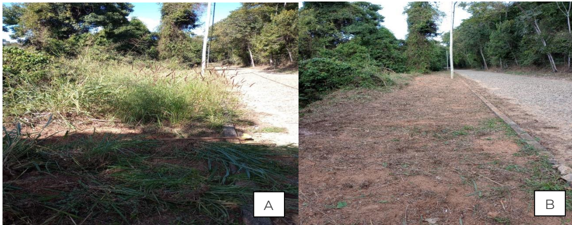
Figura 29. Retirada de vegetação. A e B) Retirada de colônias para melhorar a visibilidade dos usuários em ponto de curva acentuada na estrada principal de acesso ao Lago Dom Helvécio. Junho/2023.
