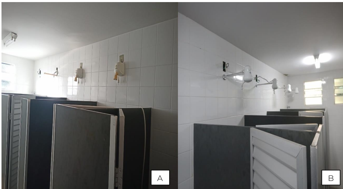
Figura 32. Alojamentos do Centro de Pesquisas. A e B) Substituição de todos os chuveiros queimados. Junho/2023.
