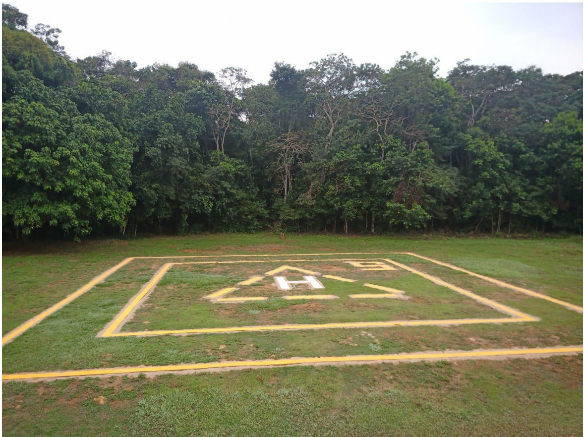
Figura 17. Heliponto. Reforma mista concluída em toda a estrutura incluindo pintura com tinta epóxi para maior durabilidade. Maio/2023.
