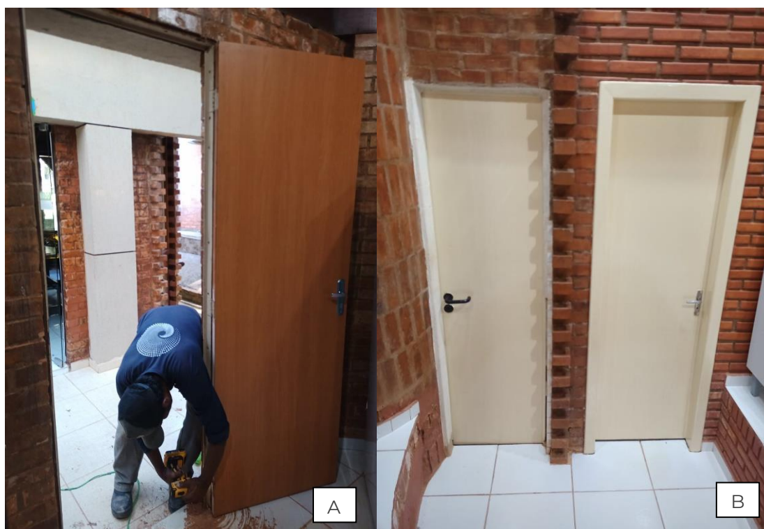
Figura 20. Cozinha administrativa A) Banheiros Sociais B) Substituições de portas, fechaduras e revestimento em esmalte sintético. Maio/2023.
