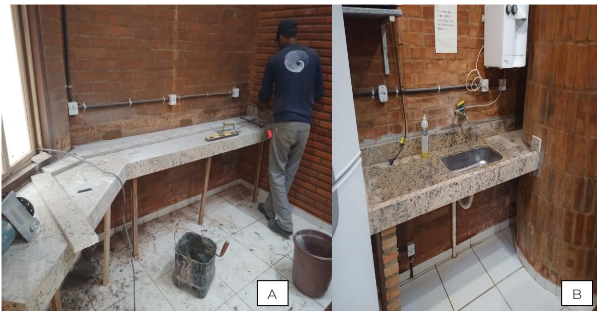
Figura 25. Cozinha administrativa A e B) Aquisição e fixação de bancada em L no granito amarelo e substituição da pia da Cozinha Administrativa. Maio/2023.
