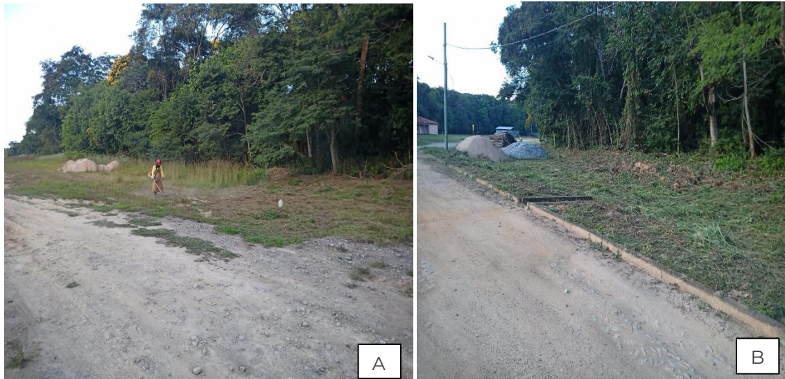
Figura 39. Centro de Manutenção. Roçada com retirada de vegetação no entorno das estruturas. Junho/2023.
