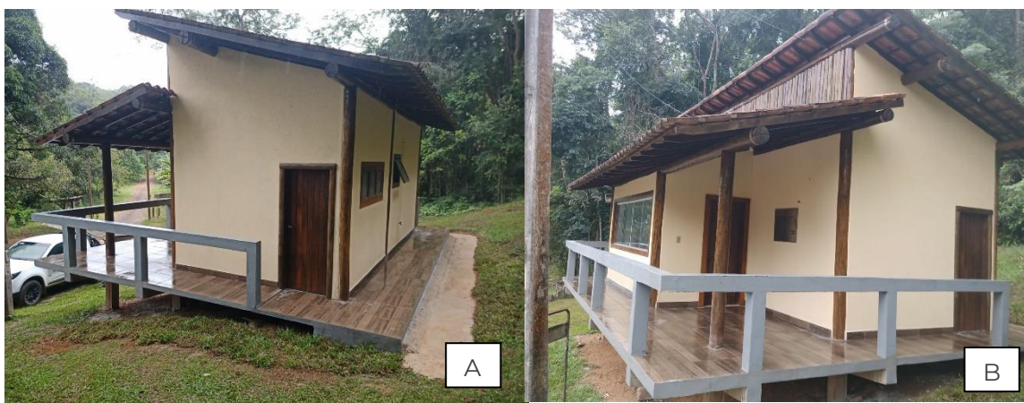
Figura 41. Centro de Fiscalização do Salão Dourado. A e B) Assentamento de piso e rodapé em cerâmica anti-derrapante no entorno da estrutura. Maio/2023.
