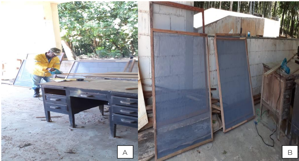
Figura 6. Preparação de molduras. A) Quadros com telas contra insetos. B) Reformas e fabricações de novas molduras (quadros) com telas novas contra insetos, para todas as janelas dos alojamentos do Centro de Pesquisa. Abril/2023.
