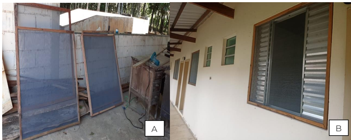
Figura 15. Quadros com telas contra insetos finalizados. A) Quadros com telas contra insetos. B) Reformas e construções de novos quadros com telas contra insetos finalizadas e fixação destes em todas as janelas dos alojamentos do Centro de Pesquisas. Maio/2023.
