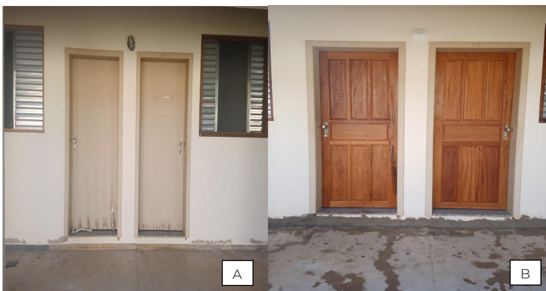
Figura 33. Alojamentos do Centro de Pesquisas. A e B) Substituições de 8 portas, fechaduras e revestimentos em verniz Osmocolor. Junho/2023.
