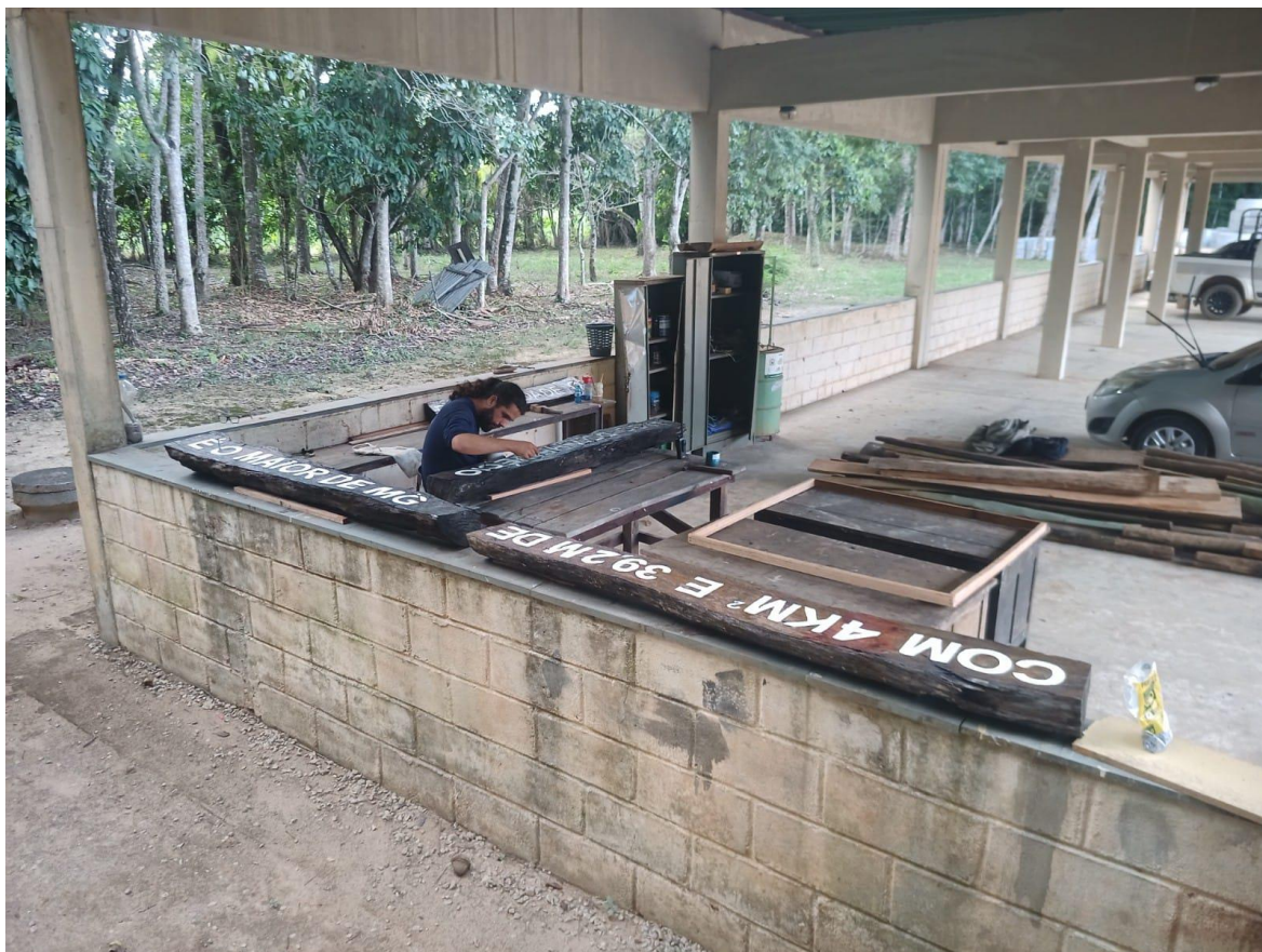
Figura 4. Restauração de placas de sinalização. Execução de restauração dos letreiros das placas educativas em toda península da UC. Abril/2023.
