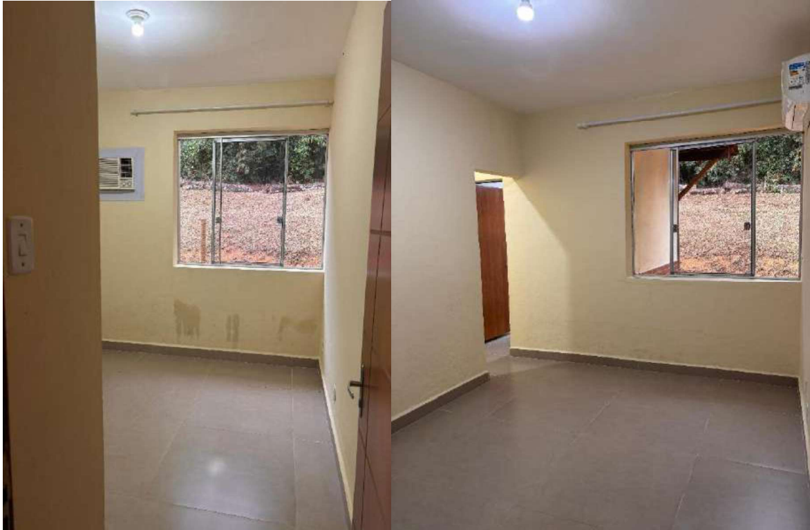
Figura 3. Manutenção área interna da residência.
