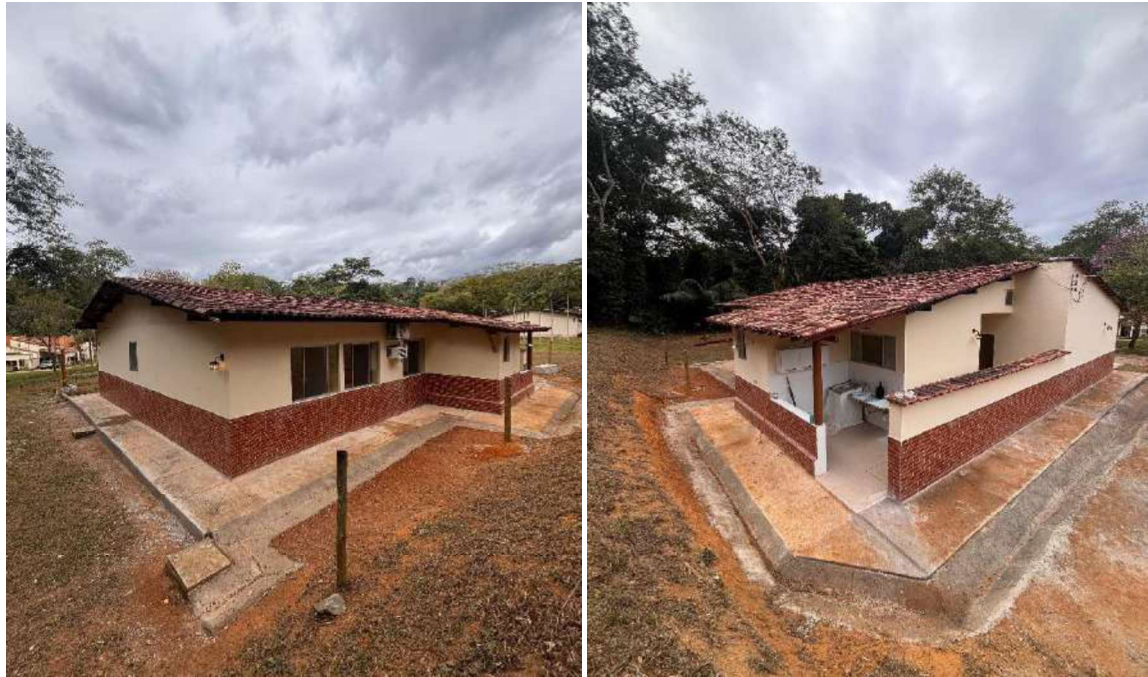
Figura 7. Visão geral dos fundos a área externa da casa institucional que está sob manutenção.
