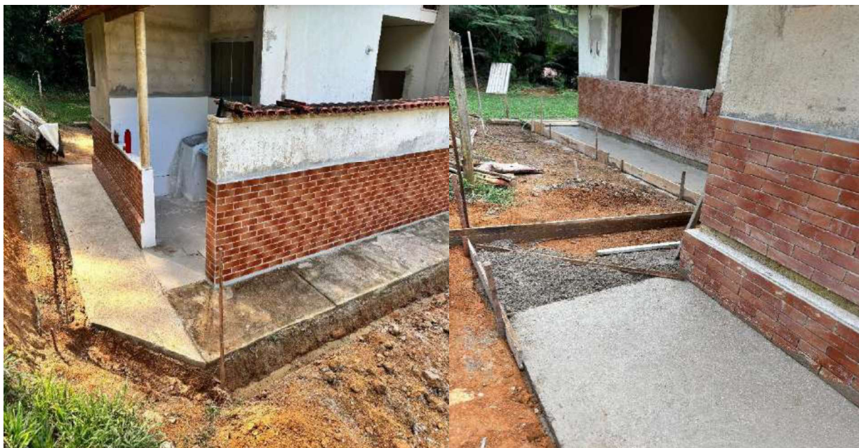
Figura 1. Manutenção área externa da residência.
