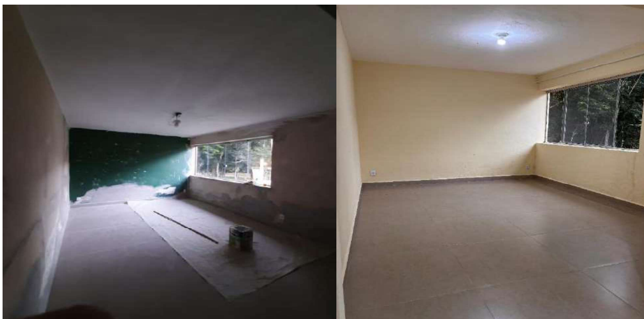
Figura 2. Manutenção área interna da residência.
