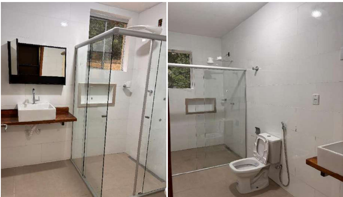
Figura 6. Manutenção dos banheiros da casa institucional.
