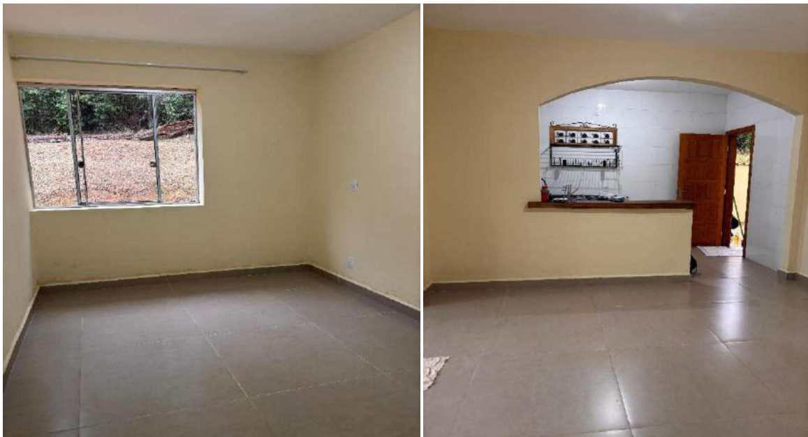
Figura 4. Manutenção área interna da residência
