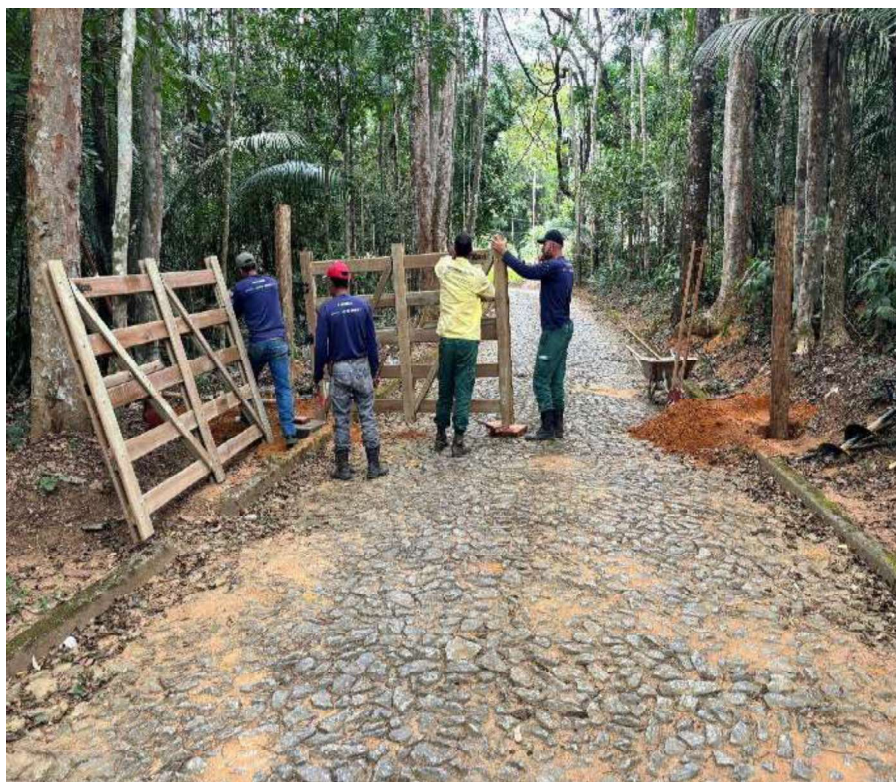
Figura 9. Processo de Instalação da porteira.
