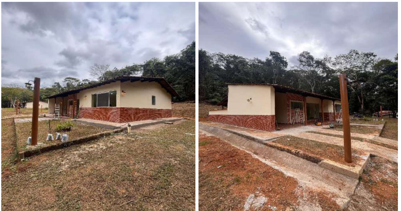
Figura 8. Visão geral da frente da área externa da casa institucional que está sob manutenção.
