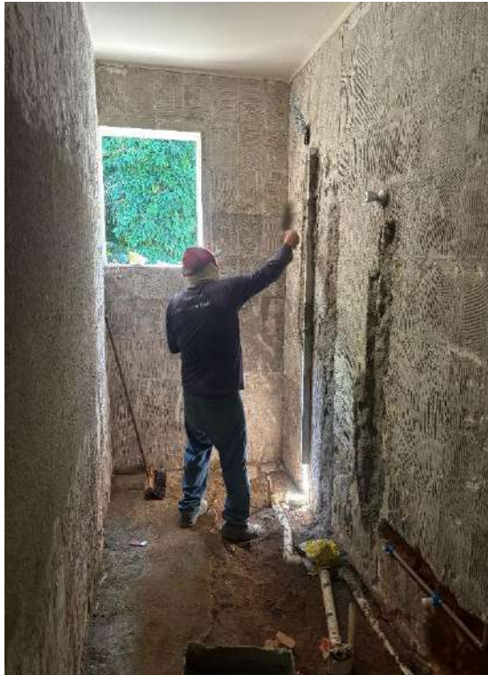
Manutenção em Casa Funcional: substituição de reboco e fixação de novo revestimento cerâmico nas paredes do banheiro.
