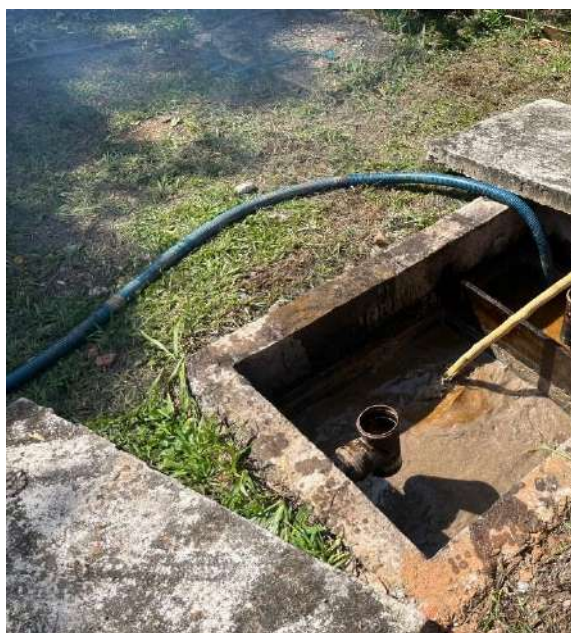
Restaurante do PERD: Manutenção e limpeza de caixa de gordura.
