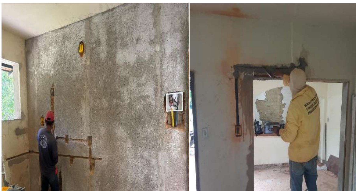
Manutenção em Casa Funcional: manutenção em conduíte, substituição de caixas de passagem, com acréscimo de novos pontos de tomadas.
