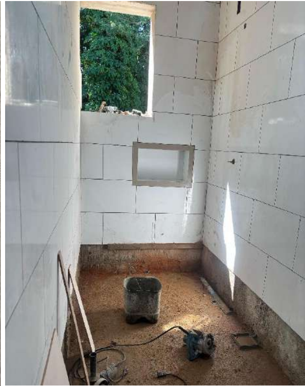
Manutenção em Casa Funcional: substituição de reboco e fixação de novo revestimento cerâmico nas paredes do banheiro.
