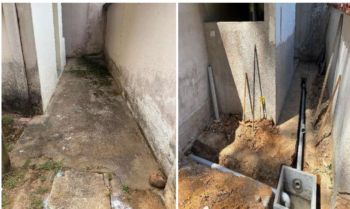
Manutenção em Casa Funcional: reposição de caixa de gordura e canos, evitando vazamentos e umidade no piso e paredes da estrutura.
