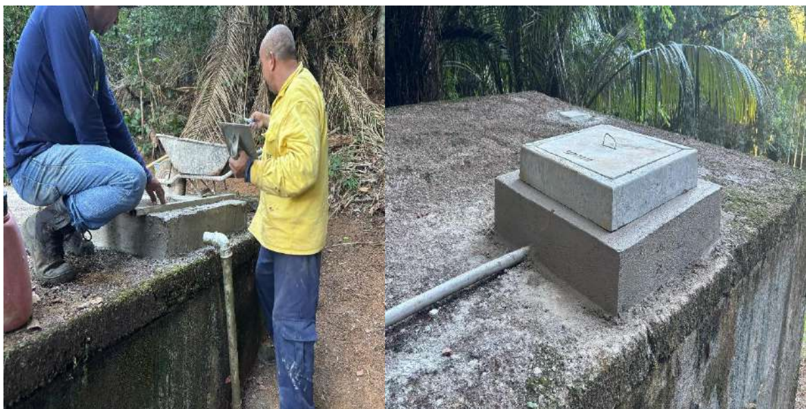
Manutenção e limpeza em caixas d'água principais na península da UC, com substituição de tampas de relevo para eliminar entradas de animais e águas de pluviais.
