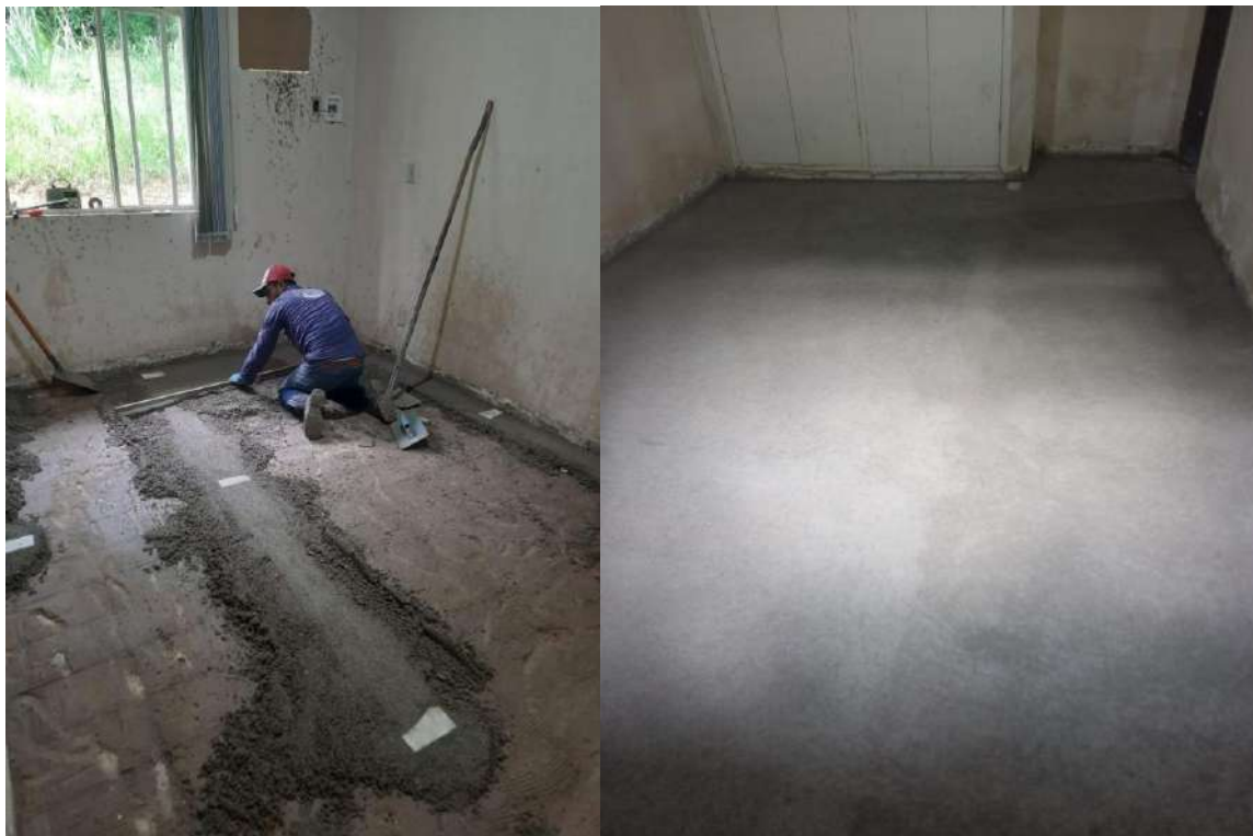
Manutenção em Casa Funcional: reposição de contrapisos, devido a problemas de aderência e baixa resistência do concreto. Considerando esses aspectos, a remoção do contrapiso existente e a execução de um novo, com materiais de qualidade e técnicas adequadas foram essenciais para garantir a durabilidade dos pisos da casa funcional.
