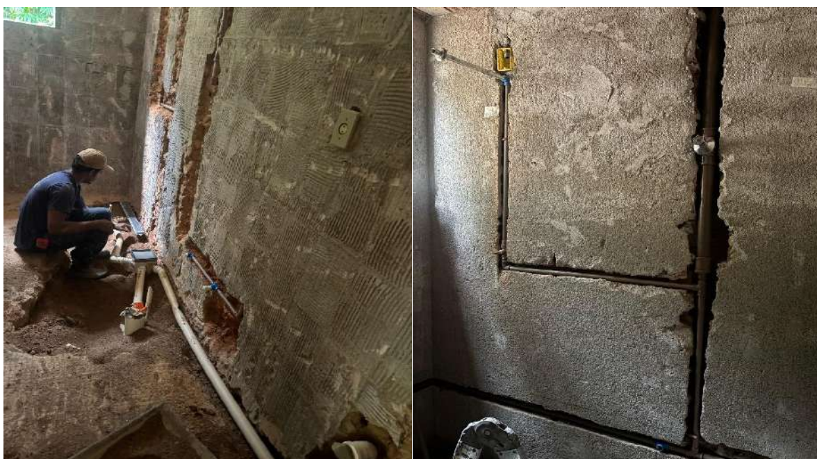
Manutenção em Casa Funcional: substituição da rede hidráulica dos 2 banheiros.
