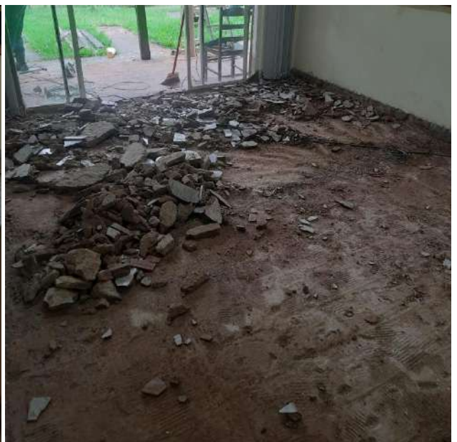
Manutenção em Casa Funcional: remoção de piso cerâmico, devido a problemas na base de assentamento, destacamento de placas e movimentação do substrato.
