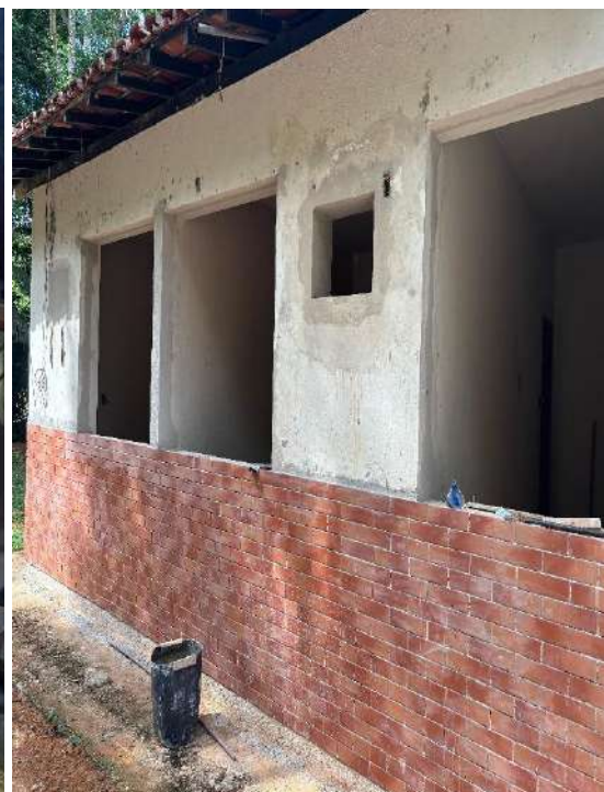
Manutenção em Casa Funcional: fixação de revestimentos em pastilhas nas paredes, a 1,50 metros de altura nas áreas externas, com a finalidade de mitigar umidade.
