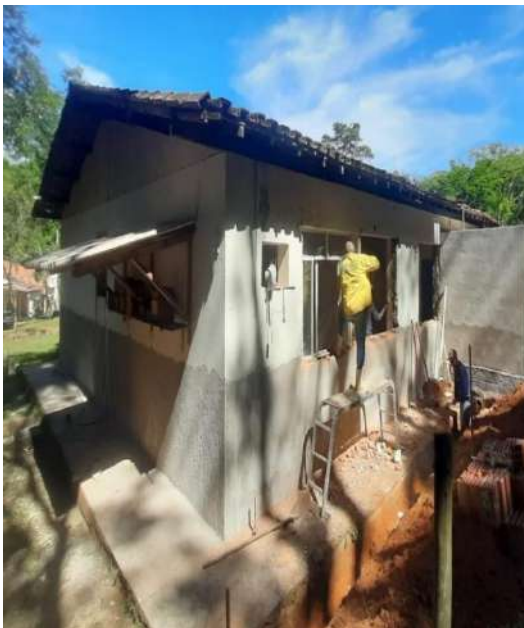
Manutenção em Casa Funcional: remoção de todas as janelas com aplicação de novos preenchimentos com massa de área e cimento (espala).
