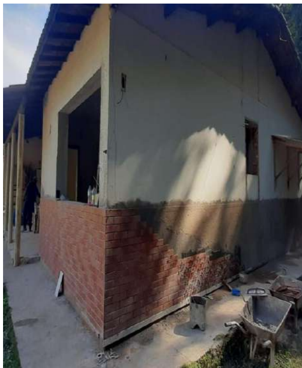
Manutenção em Casa Funcional: fixação de revestimentos em pastilhas nas paredes, a 1,50 metros de altura nas áreas externas, com a finalidade de mitigar umidade.
