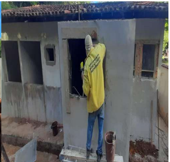
Manutenção em Casa Funcional: remoção de todas as janelas com aplicação de novos preenchimentos com massa de área e cimento (espala).
