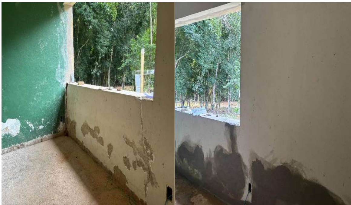
Manutenção em Casa Funcional: manutenção em todas as paredes no interior da casa, com remoção de partes danificadas pela umidade e aplicação de nova massa de boa qualidade.
