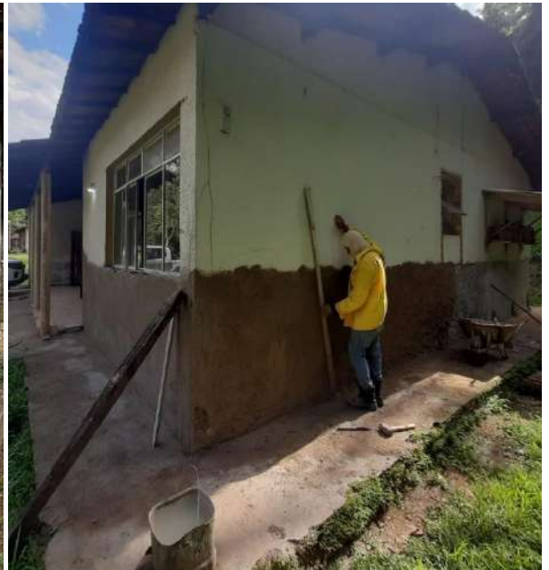
Manutenção preventiva em Casa Funcional: aplicação de novas camadas de impermeabilizante para evitar infiltrações, correção de nivelamento, ajustes na base da parede para evitar desalinhamentos e problemas futuros.
