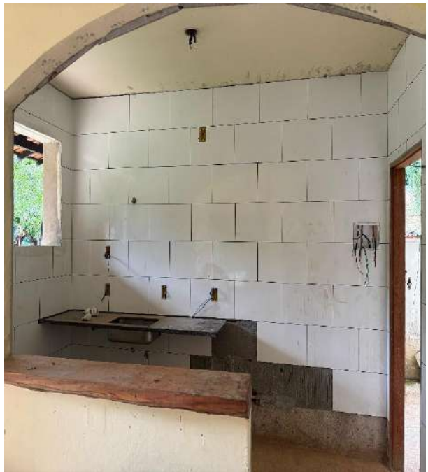
Manutenção em Casa Funcional: manutenção hidráulica, fixação de mais pontos elétricos, substituição de todo reboco com reposição do revestimento cerâmico.
