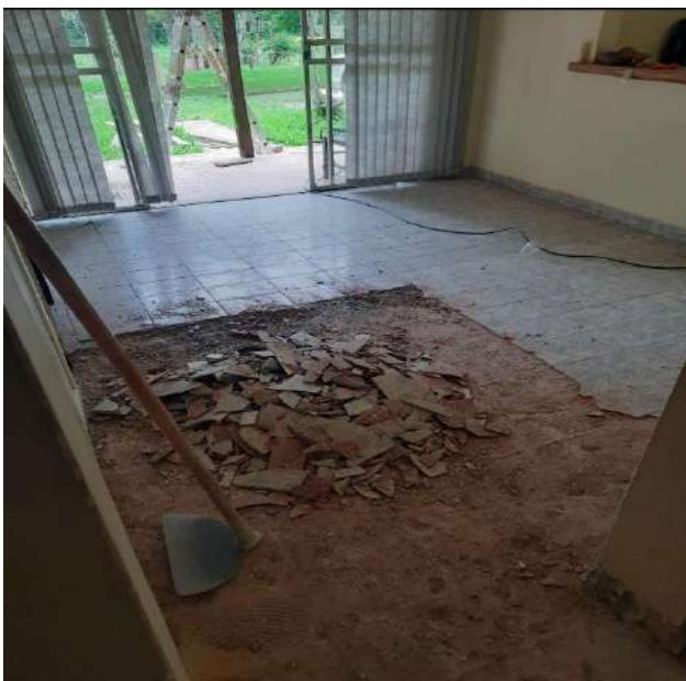
Manutenção em Casa Funcional: remoção de piso cerâmico, devido a problemas na base de assentamento, destacamento de placas e movimentação do substrato.
