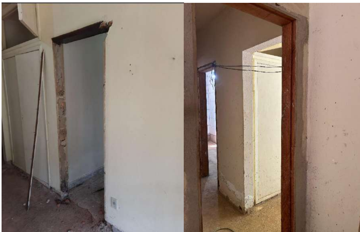
Manutenção em Casa Funcional: substituição de todos os batentes de portas com madeira prejudicada e cupim.
