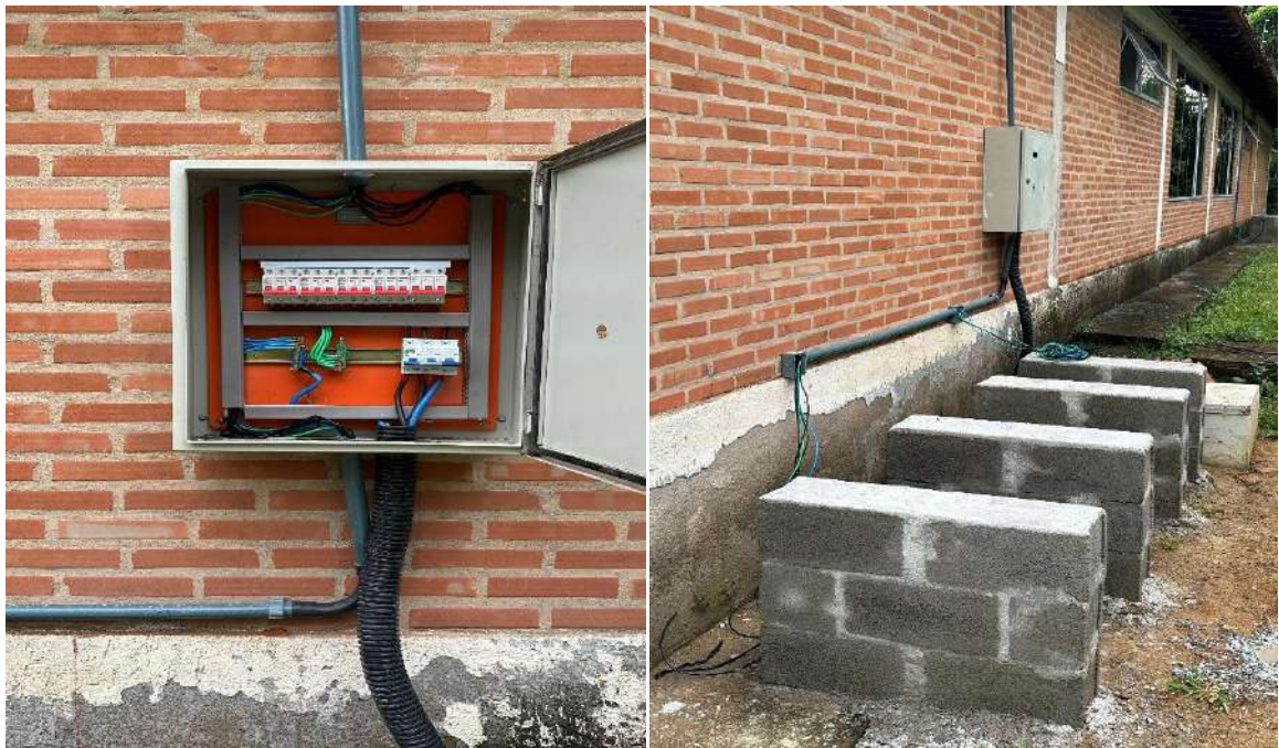
Centro de Treinamento do PERD: Manutenção elétrica em todos os pontos de alimentação de ar-condicionado das 6 salas.
