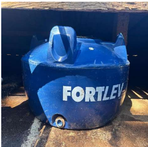
Manutenção em Casa Funcional: manutenção em hidráulica-mestre, com implantação de nova caixa d'água de 1.000 litros de polietileno.
