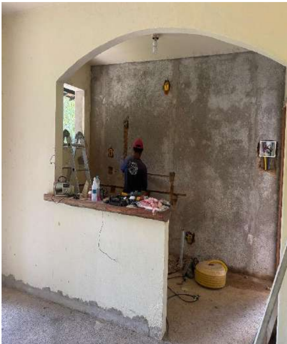
Manutenção em Casa Funcional: manutenção hidráulica, fixação de mais pontos elétricos, substituição de todo reboco com reposição do revestimento cerâmico.
