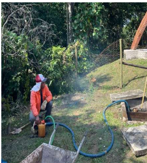
Restaurante do PERD: Manutenção e limpeza de caixa de gordura.
