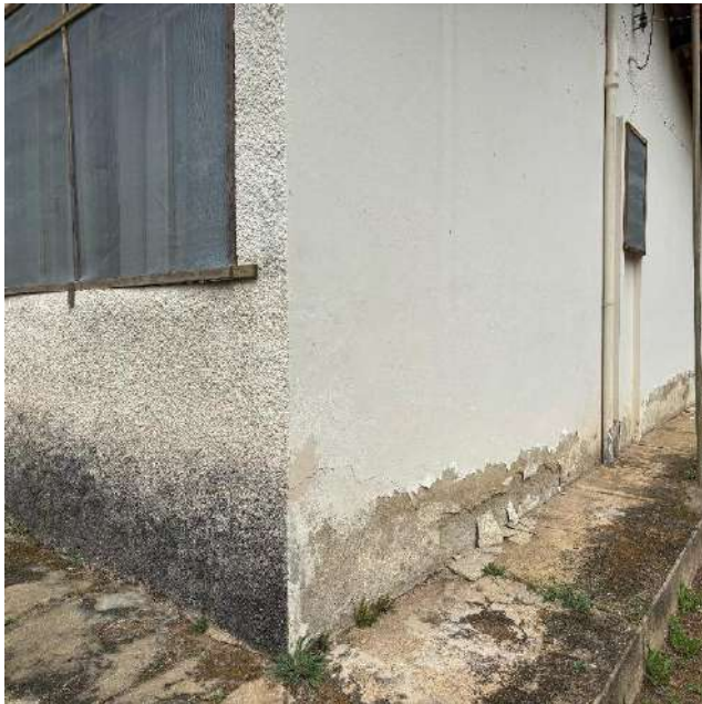
Manutenção preventiva em Casa Funcional: aplicação de novas camadas de impermeabilizante para evitar infiltrações, correção de nivelamento, ajustes na base da parede para evitar desalinhamentos e problemas futuros.
