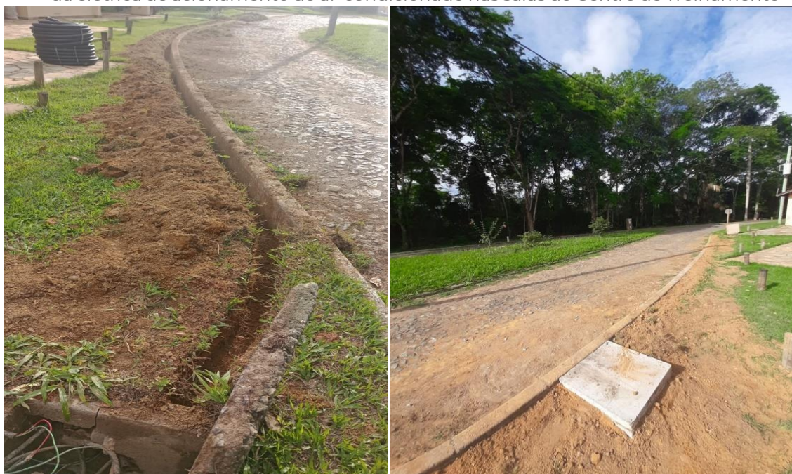
Figura 8: Manutenção e substituição de 100 metros de eletroduto corrugado para a adequação da elétrica de acionamento do ar-condicionado nas salas do Centro de Treinamento
