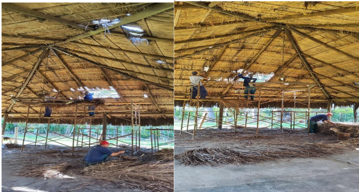
Figura 14: Manutenção na estrutura do telhado do caramanchão do Centro de Treinamento, com substituição de parte do sapé
