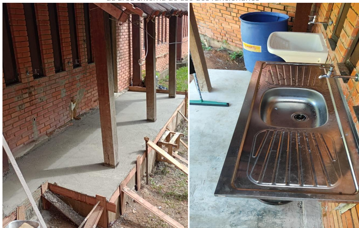
Figura 12: Manutenções em toda hidráulica do Restaurante do PERD, com substituição do piso da área externa de uso dos funcionários
