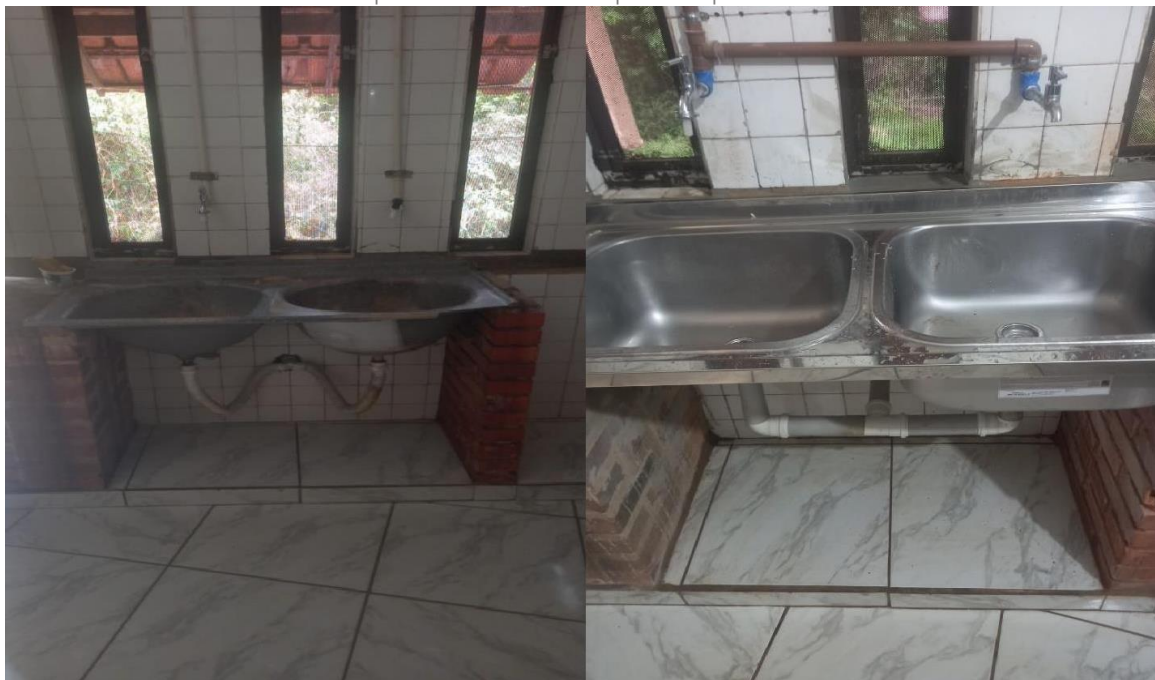
Figura 7: Manutenção de rede hidráulica no Restaurante do PERD, com substituição de tanque duplo em marmofibra por tanque de inox
