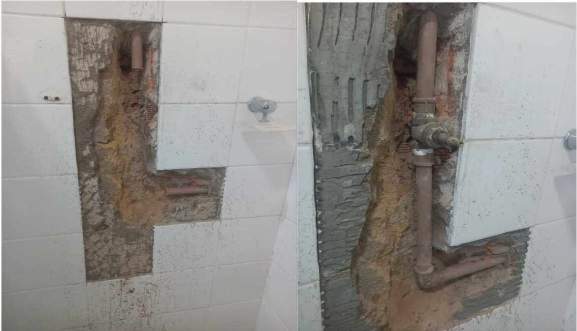
Figura 17: Manutenção de rede hidráulica do banheiro do Alojamento Traíra, com substituição de registro e reposição dos revestimentos em azulejo
