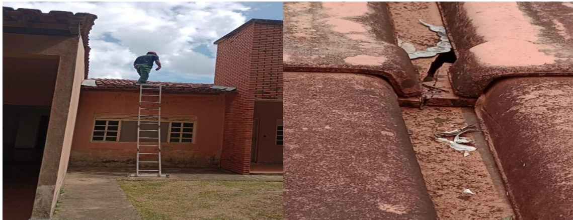
Figura 4: Manutenção e substituição de telhas quebradas no telhado dos alojamentos funcionais do Campo de pouso.
