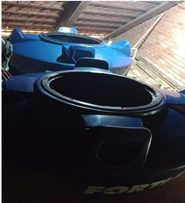
Figura 13: Manutenção na rede hidráulica e substituição de caixas d'água do Restaurante do PERD por caixas d'água de polietileno.
